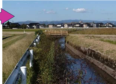
三方コンクリート打や底打張り ブロック護岸の水路へ整備
